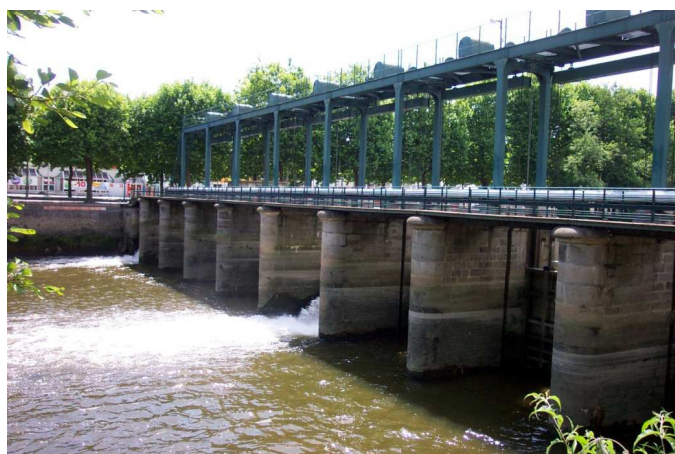
Figure 10 : Barrage de Caen situé sur le Cours Montalivet servant à alimenter et réguler le niveau d'eau du canal de Caen à la mer. Premier obstacle du plus grand fleuve bas-normand, situé à près de 18 kilomètres de la limite transversale de la mer, l'ouvrage marque ainsi le fond de l'estuaire de l'Orne. (© Arnaud RICHARD – ONEMA).
