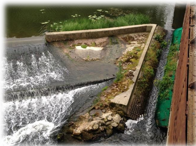
Figure 28 : Rampe anguille au niveau du barrage du Grand Moulin
